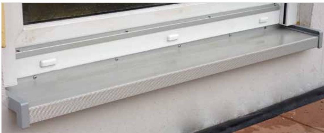
*Ansicht eines eingebauten Balkonaustrittsprofils. Die Absiegelung erfolgt ringsum durch einen witterungsbeständigen PU-Dichtstoff.*
